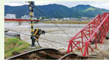
上田電鉄別所線千曲川橋梁の崩落
