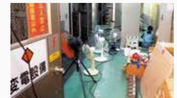
水没した電気室内を扇風機で乾燥させながらの復旧作業
