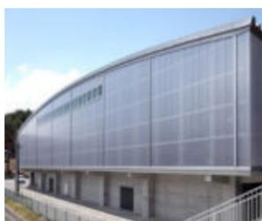
ポリカーボネート樹脂製高断熱中空パネル「ルメウォール」施工例
