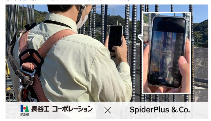
長谷工では、2018年より建設業向けアプリ SPIDERPLUS<sup>※1</sup>(以下、本アプリ)を導入し、図面・工事写真などの管理で活用を進めておりますが、2022年4月に、本アプリの機能に加え、鉄筋継手工事の品質管理の補助ツールとして「ガイドライン機能」・「計算機能」を共同開発し、実際のマンション建設現場で試験運用を行い、本格運用を開始しました。
