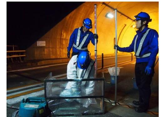
【道路】コンクリート舗装版の空隙充填
