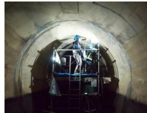
【FRT工法】覆工背面の空洞充填工事
