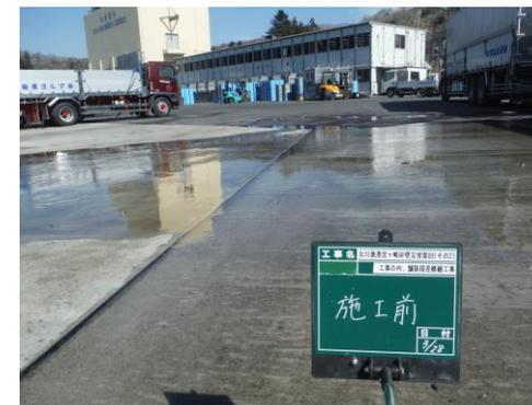
【港湾】地盤沈下によって段差が生じ水溜まりができた港湾荷下ろし岸壁
