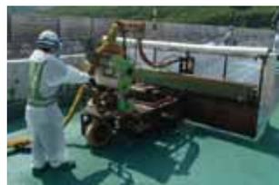
バインダ散布ロボットを活用したHQハイプレxAU工法
