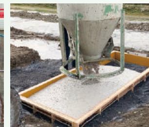
Placing (bucket)
