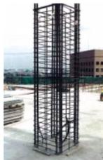
高強度せん断補強筋1275
