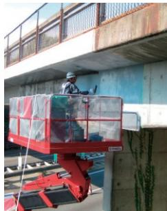
「ボンドKEEPメンテ工法 VM-3」を施工し、橋梁のコンクリートの剥落を防止しています。
