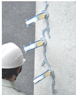
コニシ独自で開発したシリンダーを使い、低圧・低速でエポキシ樹脂を注入する「ボンド シリンダー工法」。ひび割れ箇所から建物内部に水が浸入し、内部の鉄筋が発錆するのを防ぎます。
