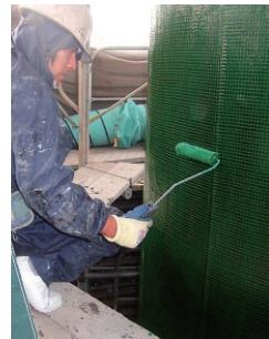
橋脚にカーボンやアラミド繊維を接着剤で巻きつける「ボンド連続繊維シート補強工法」で耐震補強を行います。
