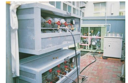
阪神・淡路大震災の際に設置したCNG<sup>②</sup>による移動式ガス発生装置(上)と仮設風呂設備(下)
