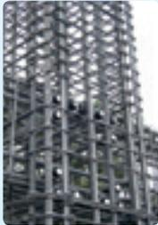
主にマンションなどの柱や梁に使用する鉄筋に部分的な焼入れを行い、1本の鉄筋に二つの強度を混在させた製品です。鉄筋使用量の低減や、広い室内空間の確保に貢献しています。
