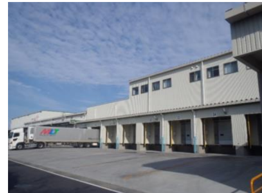
関東地区のチルド品物流倉庫
