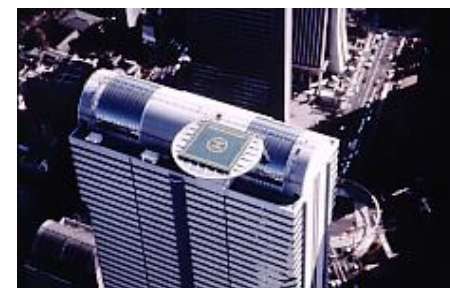
〔ビニルエステル樹脂〕 (左:耐食タンク・配管、右:ビル屋上ヘリポート用FRP防水)
